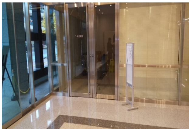
【1階の店頭出入口】
