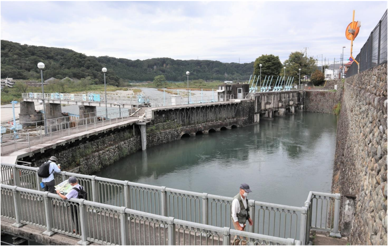
多摩川から玉川上水に水を取り入れる羽村の堰。玉川上水の出発点です。
